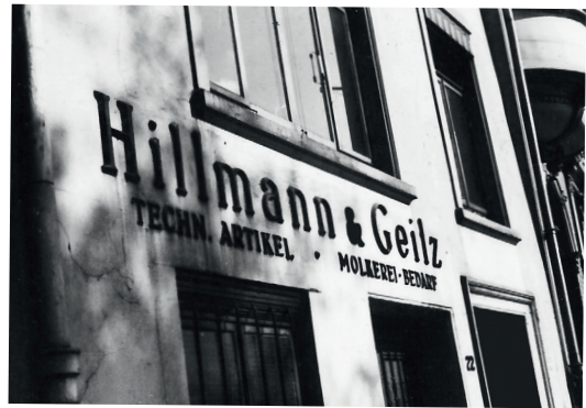
Ein Bild aus alten Zeiten vom Hillmann & Geitz-Stammhaus an der Schlachte, mitten in der Bremer Innenstadt
